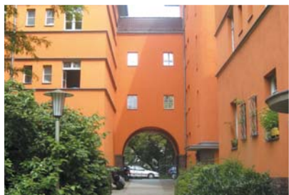
denkmalwerte Wohngebäude Ostender Straße
