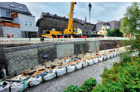
Neue Ufermauer in Mayen
