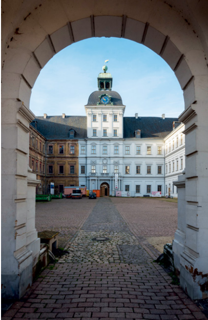
Halbseitige Sanierung des Schloss Neu-Augustusburg in Weißenfels
