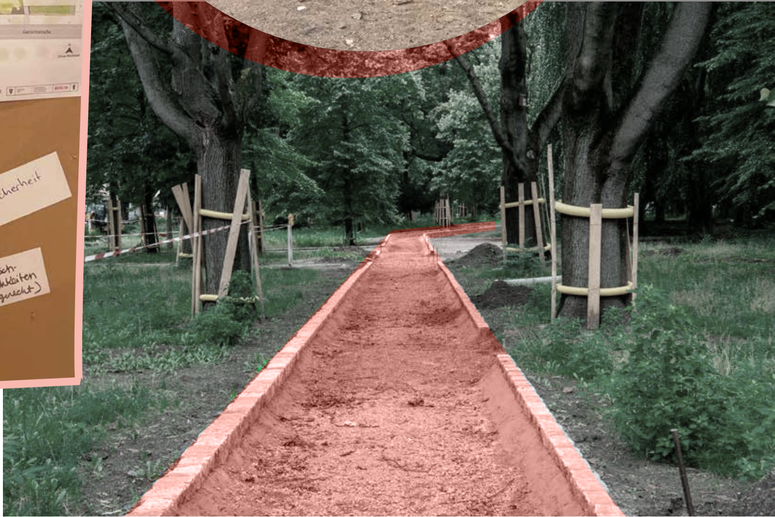
2025 Auf der Baustelle werden neue Wege angelegt
