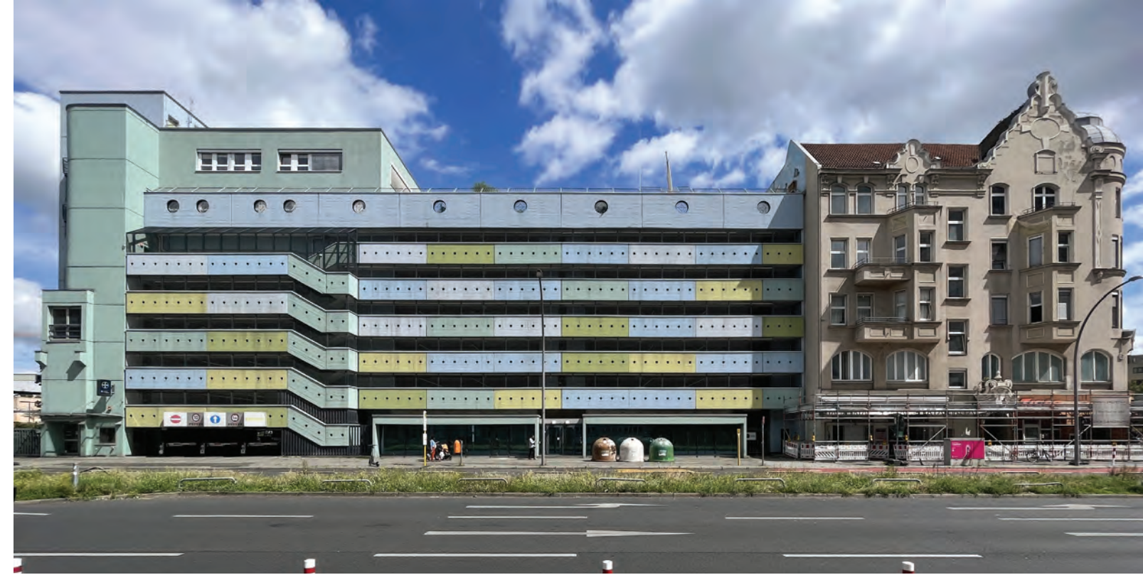
Abb. 1 Ansicht von der Müllerstraße
