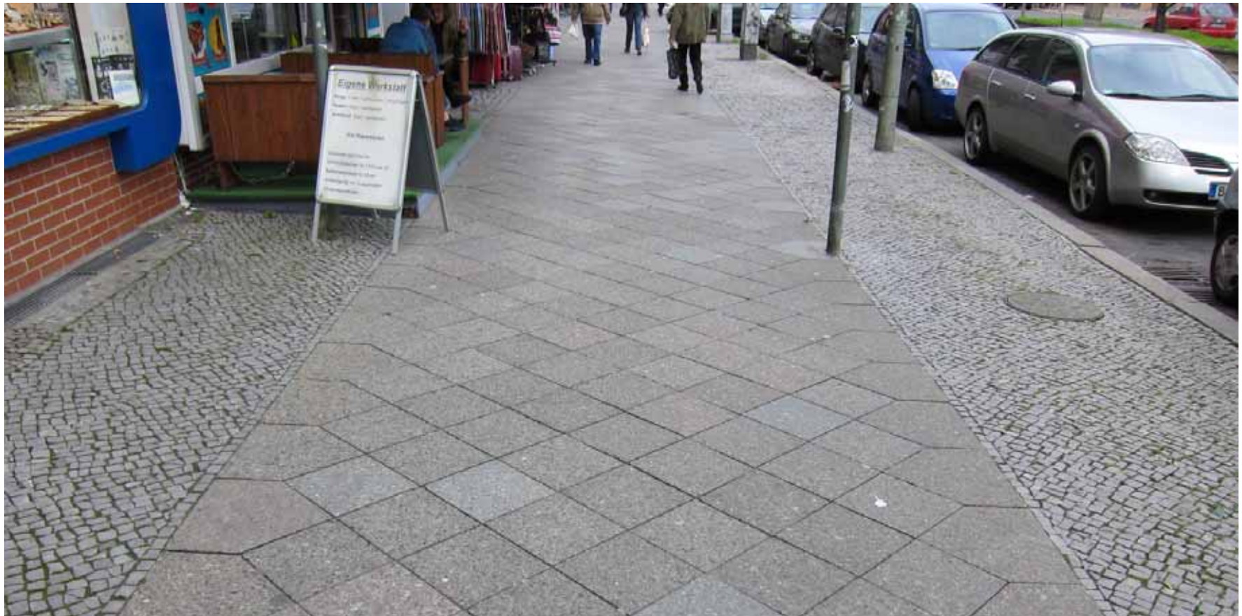
Gut erhaltener und proportionierter Gehweg
