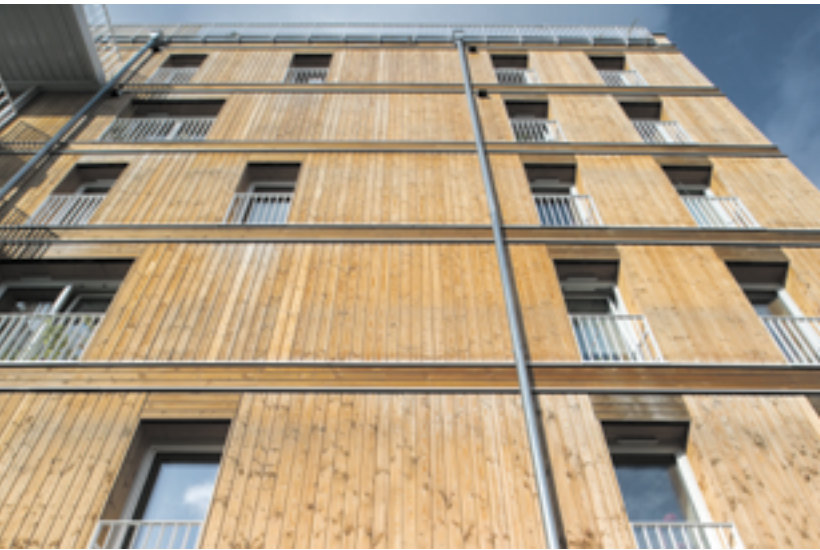
In der Weddinger Lynarstraße wurde Ende 2018 eine siebengeschossige Wohnanlage aus Holz bezugsfertig. Rund 100 Wohnungen sind auf diese Weise entstanden.
